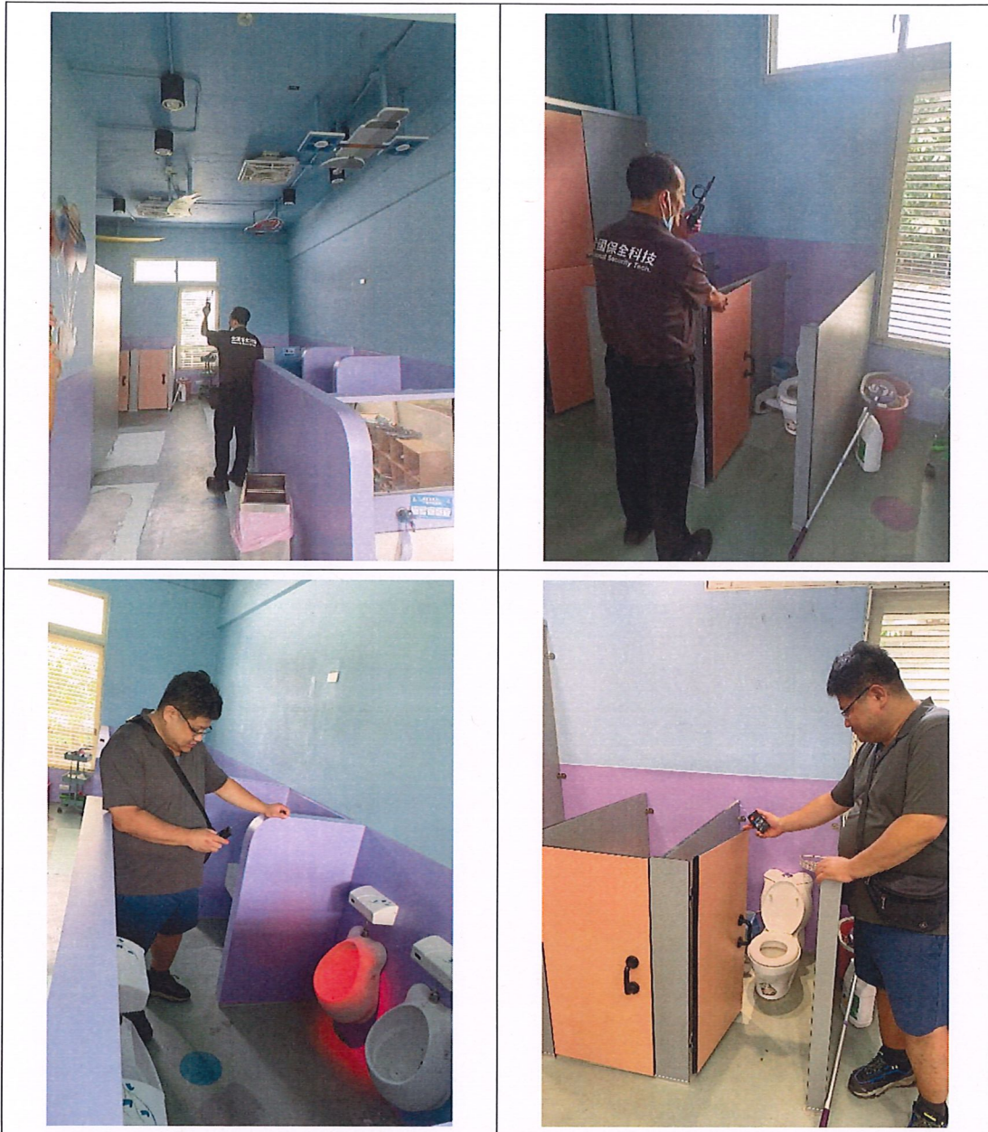
仁愛樓 2 樓廁所
